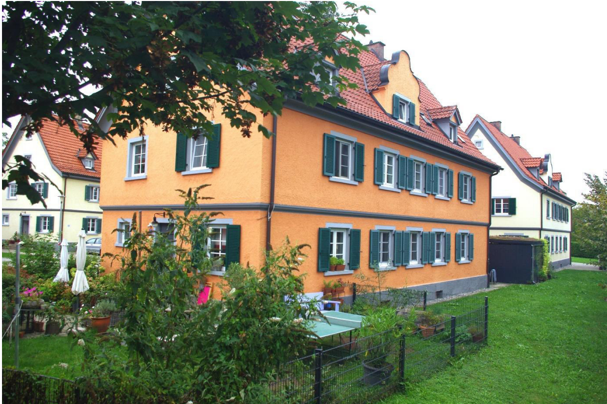
Häuser der „Kolonie Hundweiler“ aus dem städtischen Lindauer Wohnungsbauprogramm von 1922 im September 2024. Foto: Karl Schweizer.
