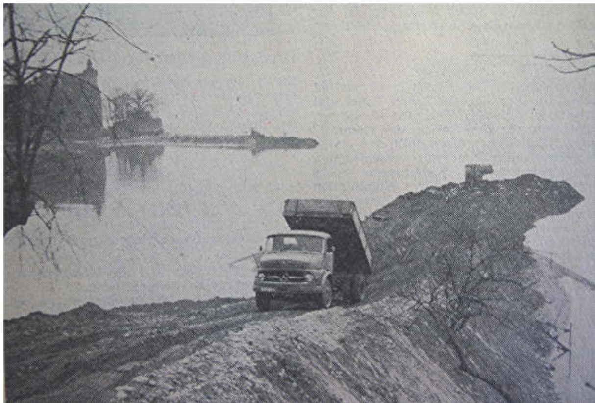
Mit den Aufschüttungsarbeiten zur Erweiterung von Lindaus „Hinterer Insel“ wurde im Januar 1968 begonnen. Foto aus der Lindauer Zeitung vom 24. Januar 1968. Repro: Schweizer.
