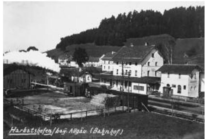
Der Bahnhof Harbatshofen mit Holzverladestelle und Güterhalle. (Quelle: Sammlung Staudter, Lindenberg)
