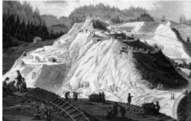
Der ebenfalls in Handarbeit erstellte Rentershofener Dammbau bei Röthenbach-Oberhäuser im Jahre 1852, gemalt von Karl Herrle.
