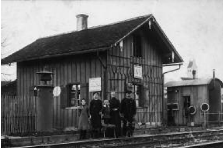
Das Bahnwärterhäuschen in Wohmbrechts, welches 1917/18 abgebrochen wurde und von serbischen Kriegsgefangenen wieder aufgebaut werden musste.
