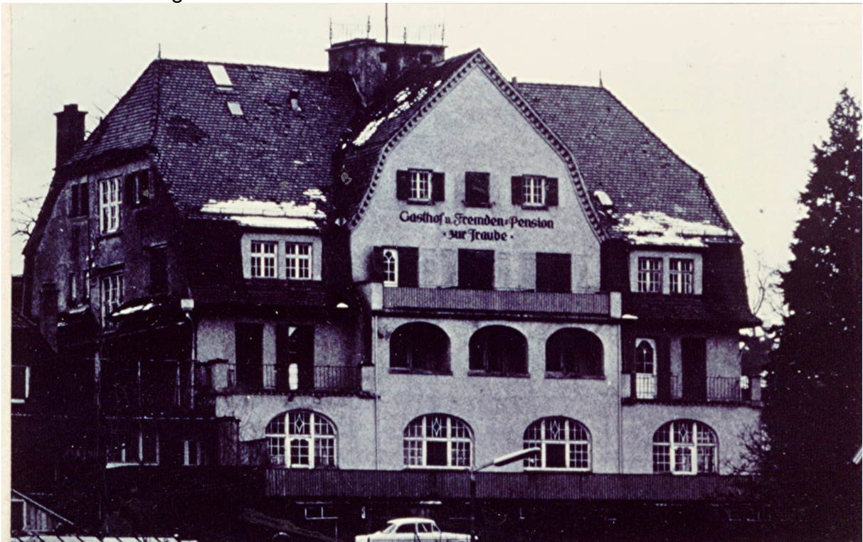
Das ehemalige Hotel „Traube“ in Enzisweiler oberhalb des Bahnhofes, heute das Einkaufszentrum, kurze Zeit vor seinem Abbruch 1978, in dessen Räumen im August 1948 die 9. Interzonenkonferenz der Gewerkschaften Deutschlands stattfand. Repro: Sammlung Schweizer.
